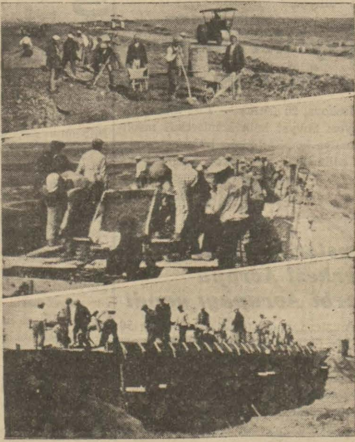
Edirne İstanbul yolu inşaatından bir görünüş
